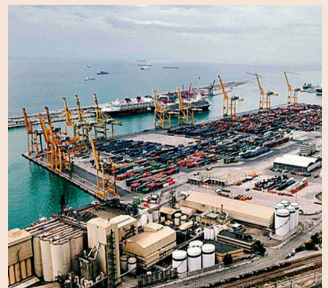
Vista aérea del Puerto de Barcelona, donde Agsa tiene su sede.
